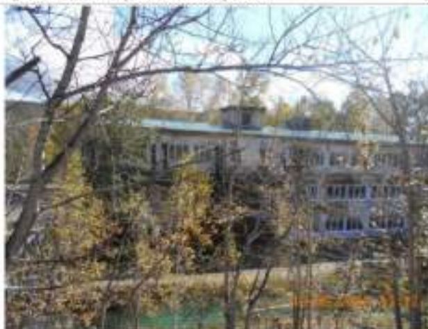
Фотография №2.9. Вид на крышу АБК
