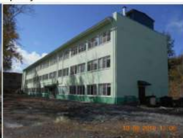
Фотография №2.6. Вид на фасад АБК и правый край, прилегающая территория к АБК
