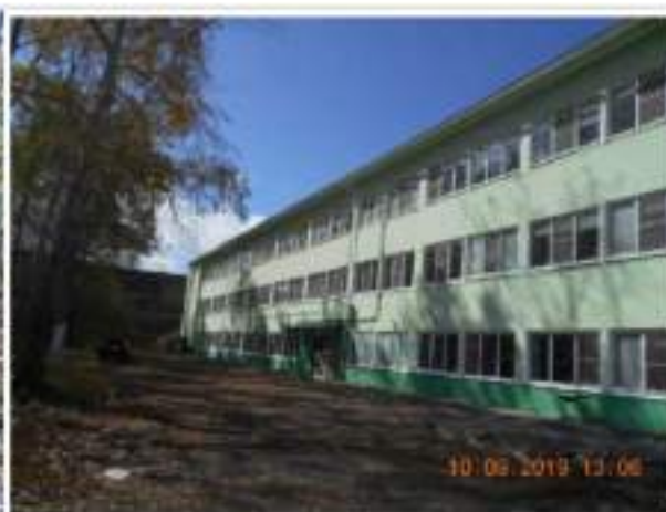
Фотография №2.4. Вид на фасад АБК, уровень отделки внешних стен, этажность, стихийную парковку
