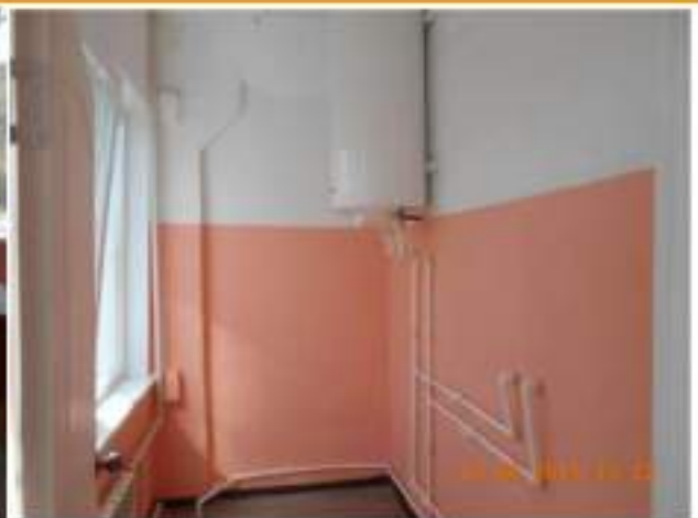
Фотография №2.14. 2-й этаж, вид на отделку помещения, систему отопления
