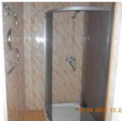
Фотография №2.15. 2-й этаж, вид душевую
