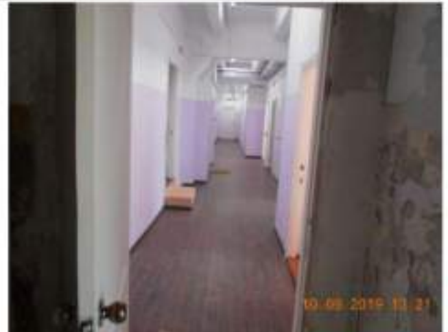
Фотография №2.16. 2-й этаж, уровень отделки коридора
