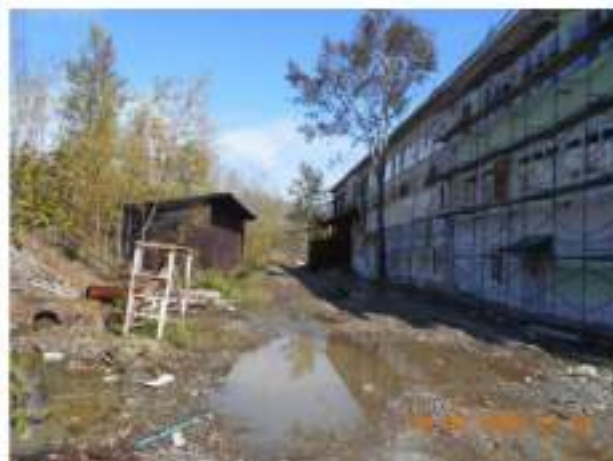
Фотография №2.8. Вид на фасад АБК и дорогу с тыльной стороны АБК, факт производства ремонтных работ
