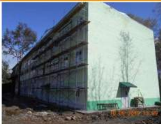
Фотография №2.7. Вид на левую и тыльную стороны АБК, прилегающую территорию, факт производства ремонтных работ
