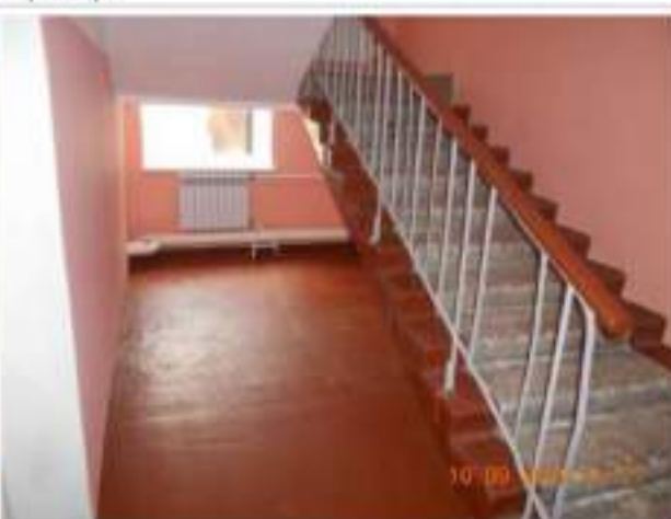
Фотография №2.12. Лестница с 1-го на 2-й этаж, вид на уровень отделки, систему отопления
