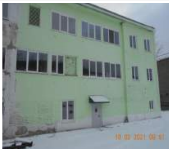
Фотография №2.6. Вид на пожарный выход АБК
