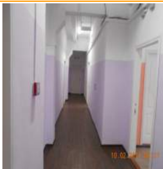
Фотография №2.16. 2-й этаж, уровень отделки коридора
