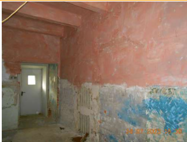
Фотография №2.21. 1-й этаж, помещения в стадии капитального ремонта
