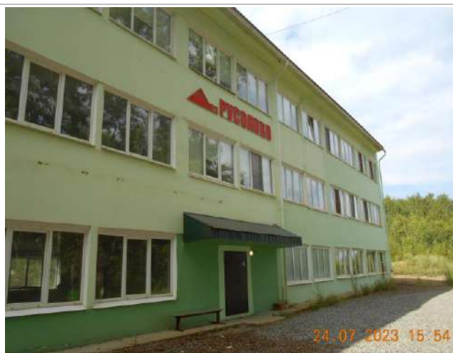
Фотография №2.5. Вид на фасад АБК и центральный вход
