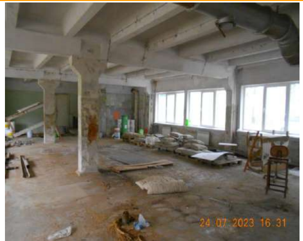
Фотография №2.22. 1-й этаж, помещения в стадии капитального ремонта
