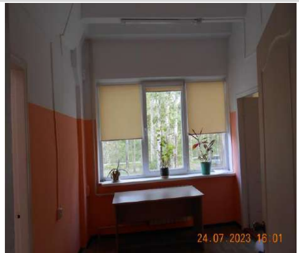
Фотография №2.14. 2-й этаж, вид на отделку помещения, систему отопления
