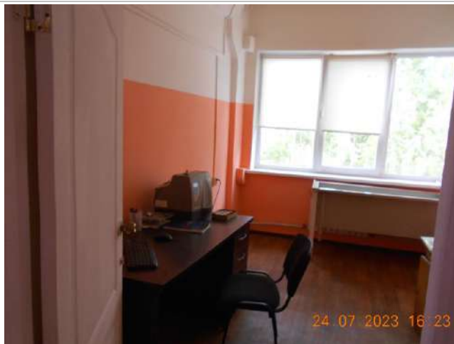
Фотография №2.17. 3-й этаж, рабочее помещение
