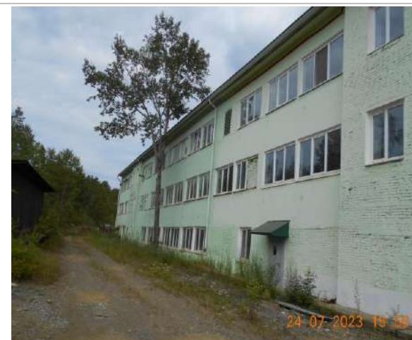
Фотография №2.8. Вид на фасад АБК с тыльной стороны АБК
