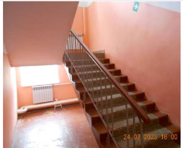
Фотография №2.12. Лестница с 1-го на 2-й этаж, вид на уровень отделки, систему отопления
