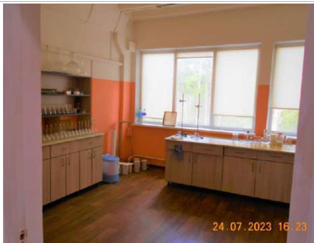
Фотография №2.19. 3-й этаж, рабочее помещение, уровень отделки
