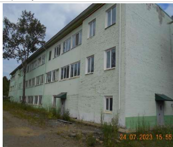
Фотография №2.6. Вид на пожарный выход АБК
