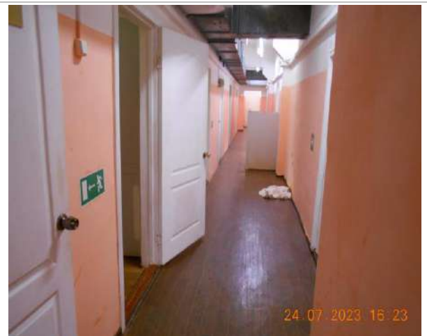
Фотография №2.20. 3-й этаж, коридор, уровень отделки
