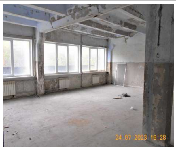
Фотография №2.24. 2-й этаж, помещения в стадии капитального ремонта
