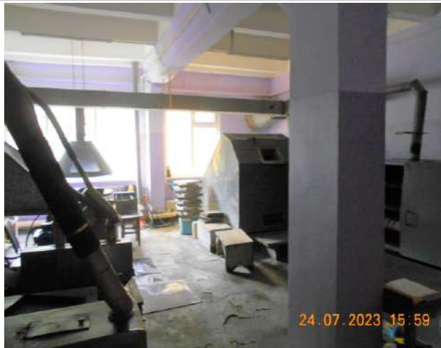
Фотография №2.11. Вид на помещение 1-го этажа, отделка пола, стен, потолка
