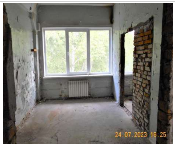
Фотография №2.26. 3-й этаж, помещения в стадии капитального ремонта
