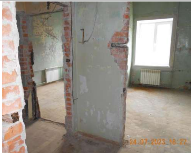
Фотография №2.23. 2-й этаж, помещения в стадии капитального ремонта
