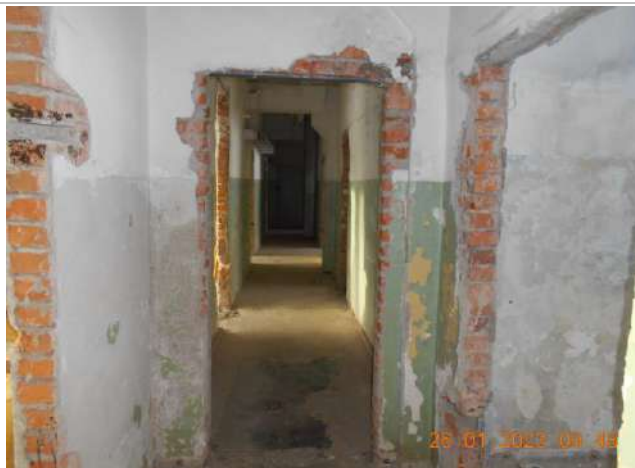
Фотография №2.25. 3-й этаж, помещения в стадии капитального ремонта
