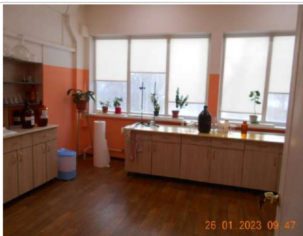
Фотография №2.19. 3-й этаж, рабочее помещение, уровень отделки
