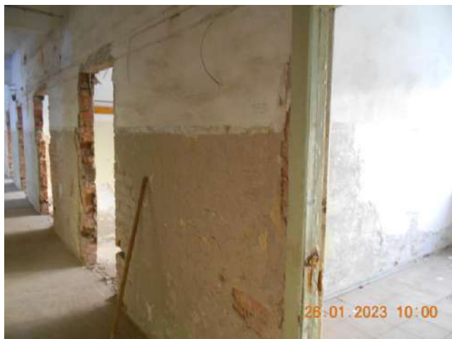
Фотография №2.23. 2-й этаж, помещения в стадии капитального ремонта
