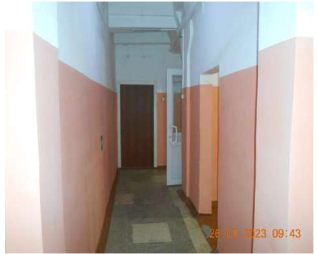
Фотография №2.10. Центральный вход в АБК, вид на отделку коридора
