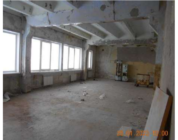
Фотография №2.24. 2-й этаж, помещения в стадии капитального ремонта
