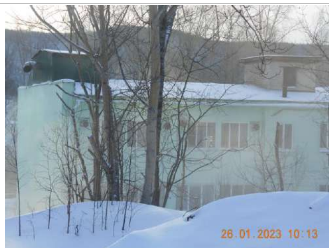
Фотография №2.7. Вид на левую и тыльную стороны АБК, крышу, прилегающую территорию
