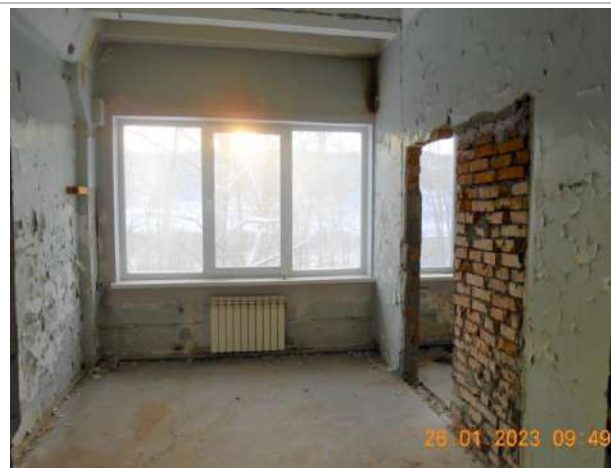
Фотография №2.26. 3-й этаж, помещения в стадии капитального ремонта
