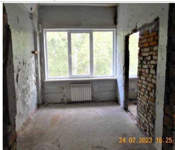
Фотография №2.26. 3-й этаж, помещения в стадии капитального ремонта
