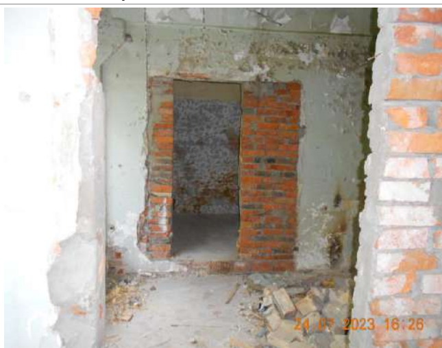
Фотография №2.25. 3-й этаж, помещения в стадии капитального ремонта
