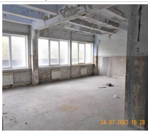
Фотография №2.24. 2-й этаж, помещения в стадии капитального ремонта
