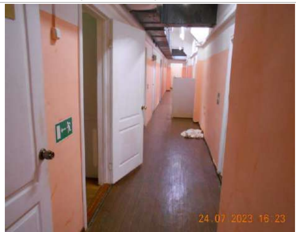
Фотография №2.20. 3-й этаж, коридор, уровень отделки
