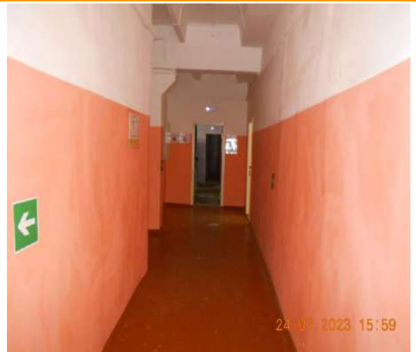
Фотография №2.10. Центральный вход в АБК, вид на отделку коридора
