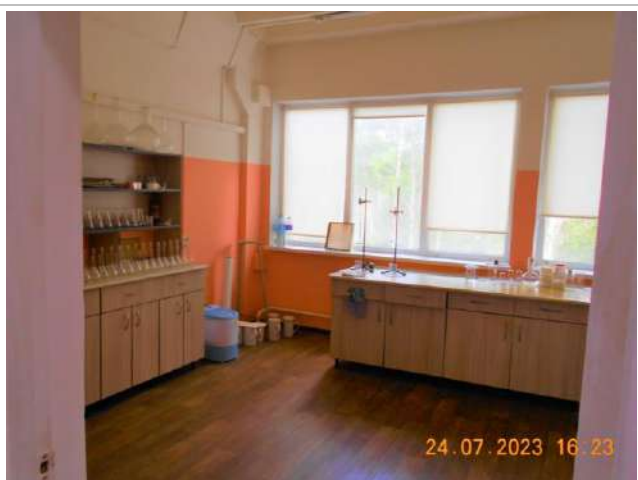
Фотография №2.19. 3-й этаж, рабочее помещение, уровень отделки
