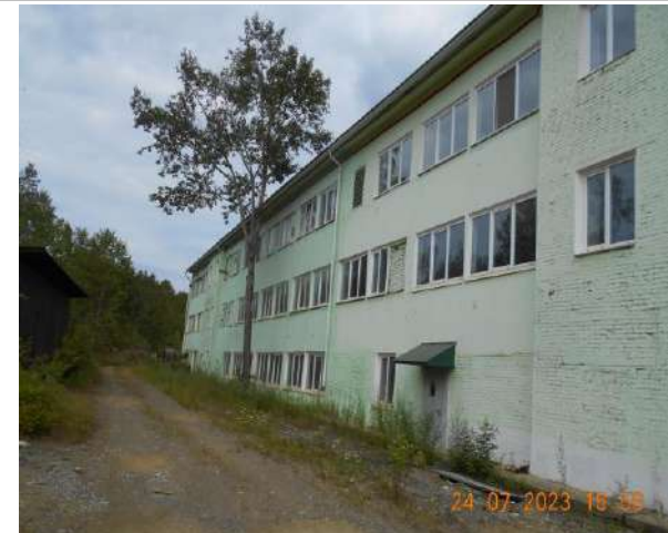
Фотография №2.8. Вид на фасад АБК с тыльной стороны АБК
