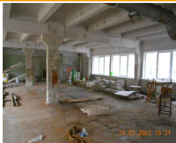
Фотография №2.22. 1-й этаж, помещения в стадии капитального ремонта
