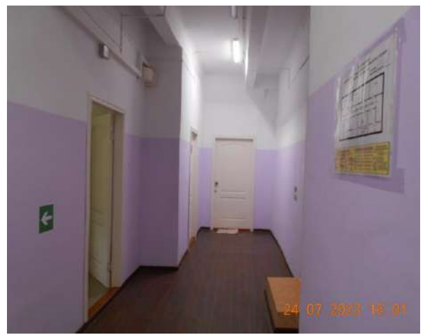
Фотография №2.16. 2-й этаж, уровень отделки коридора
