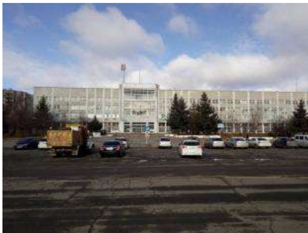
Фото 1. Внешний вид здания
