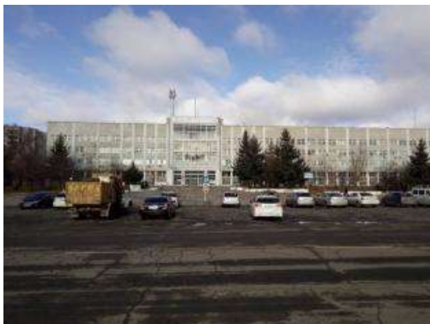
Фото 1. Внешний вид здания
