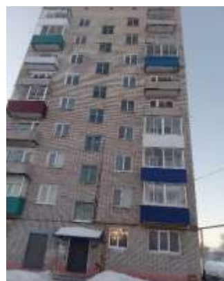
Фото 7. Вид жилого дома
