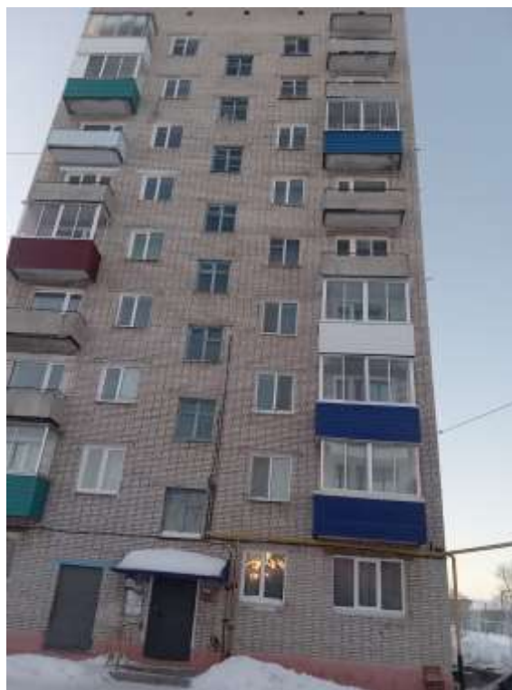
Фото 7. Вид жилого дома
