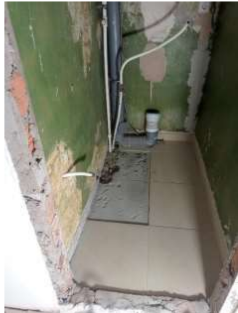
Фото 4. Санузел (5-ый этаж)
