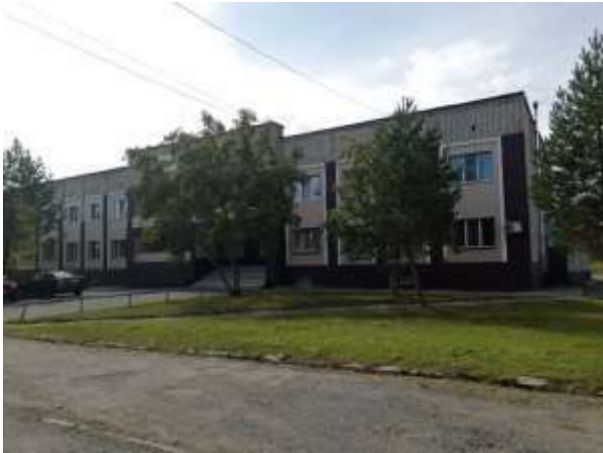
Фото 1. Внешний вид здания, фасад
