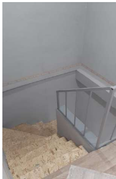
Фото 10. Лестница (6-ой этаж)
