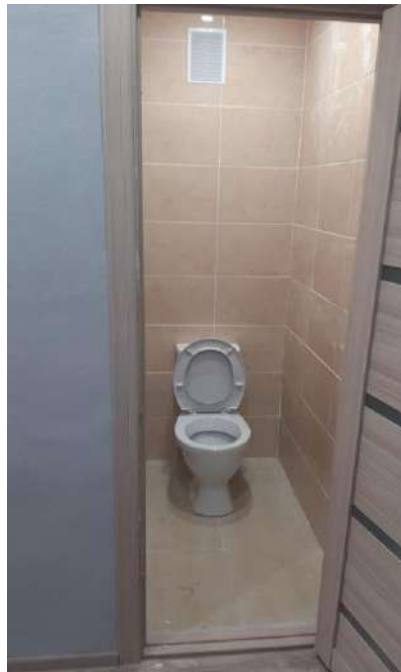
Фото 4. Санузел (5-ый этаж)
