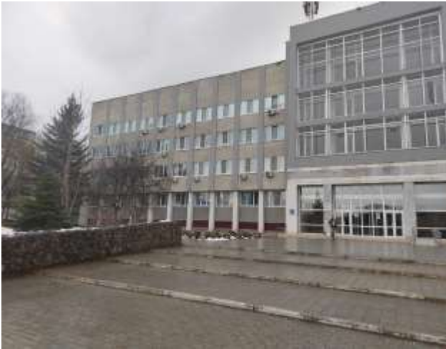
Фото 1. Внешний вид здания
