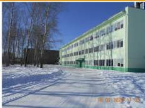
Фотография №2.4. Вид на фасад АБК, уровень отделки внешних стен, этажность, стихийную парковку
