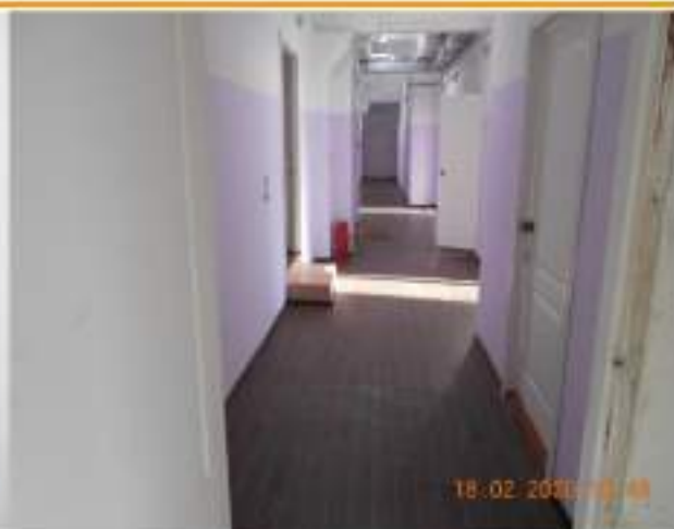
Фотография №2.16. 2-й этаж, уровень отделки коридора
