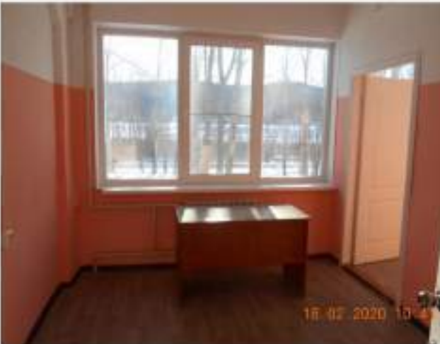
Фотография №2.13. Вид на помещение 2-го этажа, уровень отделки, окна ПВХ, радиаторы отопления
