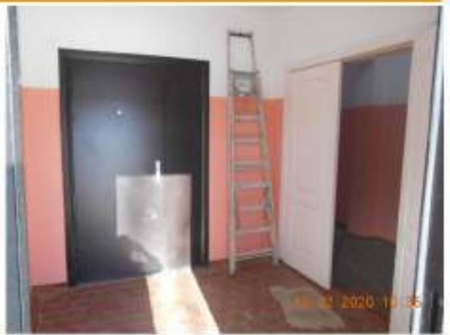
Фотография №2.10. Центральный вход в АБК, вид на отделку коридора
