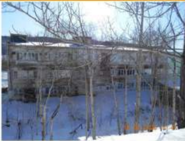
Фотография №2.9. Вид на крышу АБК
