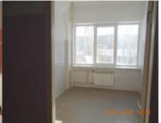
Фотография №2.14. 2-й этаж, вид на отделку помещения, систему отопления
