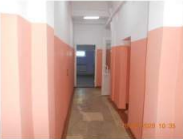
Фотография №2.11. 1-й этаж, отделка пола, стен, потолка
