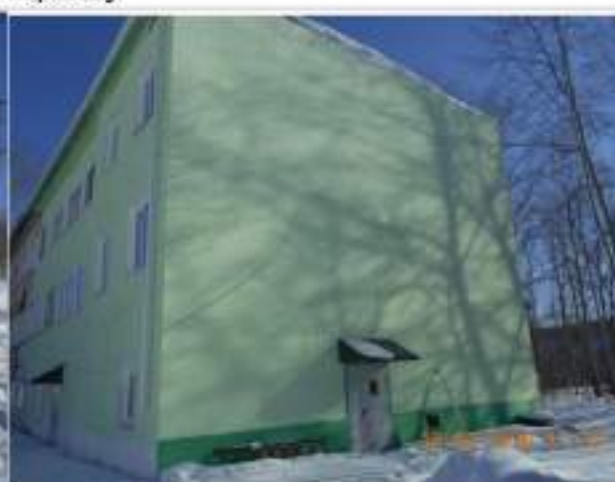
Фотография №2.6. Вид на пожарный выход АБК
