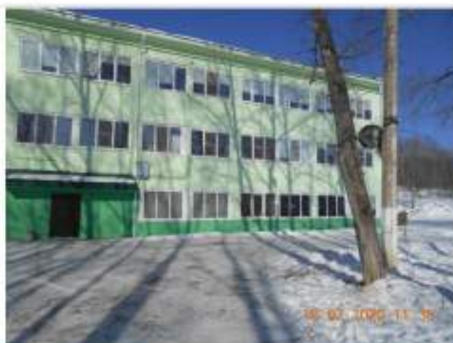
Фотография №2.5. Вид на фасад АБК и центральный вход
