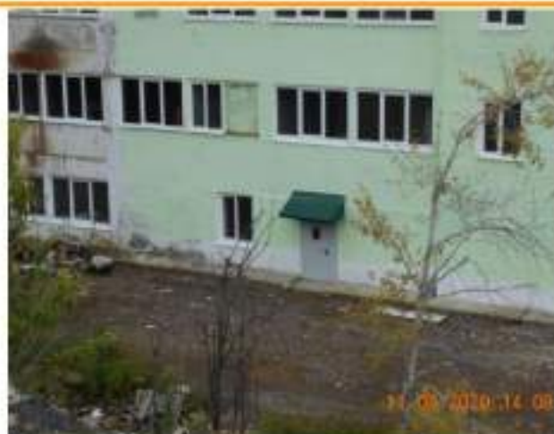
Фотография №2.9. Тыльная сторона АБК и пожарный выход
