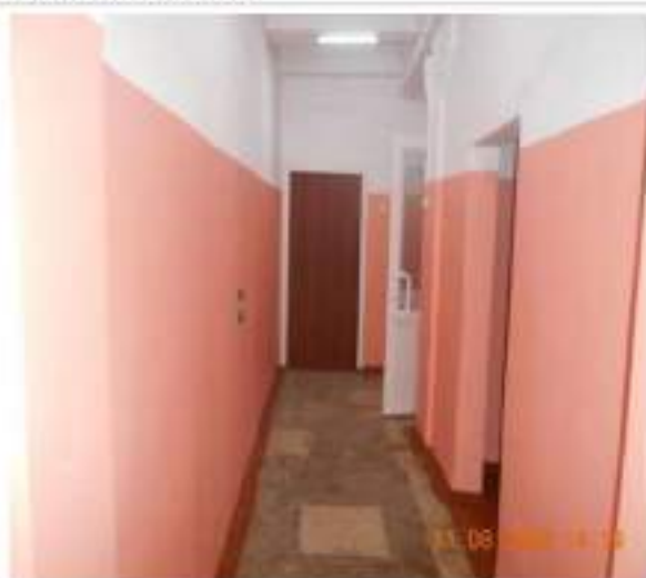
Фотография №2.11. 1-й этаж, отделка пола, стен, потолка
