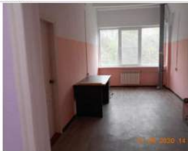
Фотография №2.13. Вид на помещение 2-го этажа, уровень отделки, окна ПВХ, радиаторы отопления
