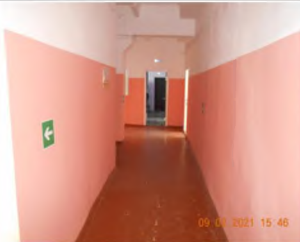
Фотография №2.11. 1-й этаж, отделка пола, стен, потолка
