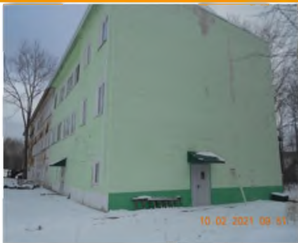
Фотография №2.9. Тыльная сторона АБК и пожарный выход
