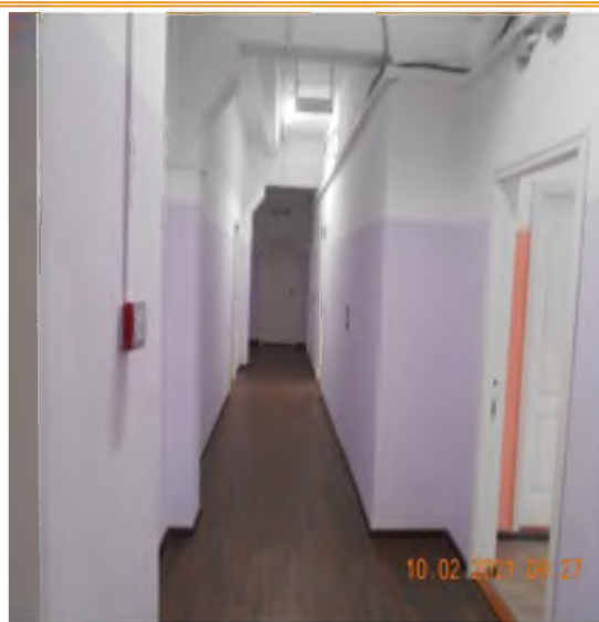
Фотография №2.16. 2-й этаж, уровень отделки коридора
