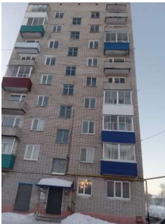
Фото 7. Вид жилого дома
