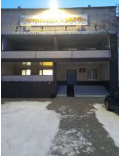
Фото 1. Внешний вид здания, фасад
