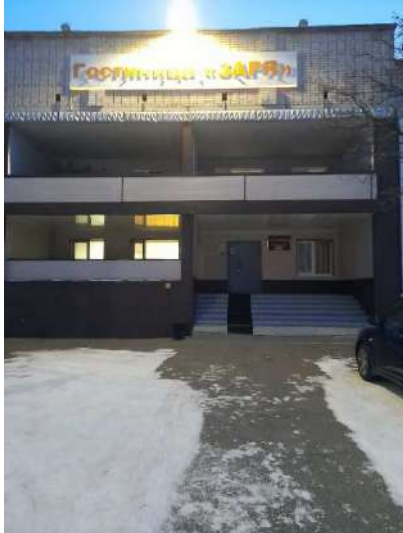
Фото 1. Внешний вид здания, фасад
