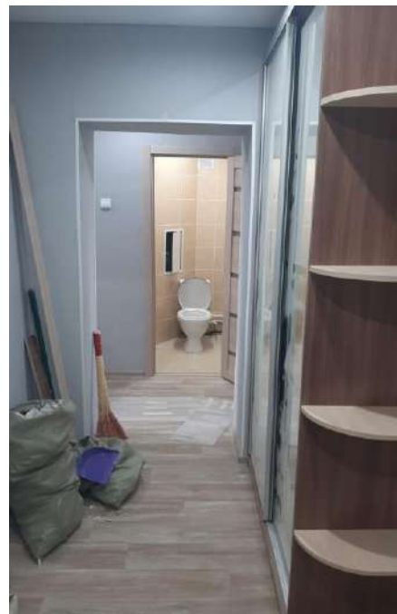
Фото 8. Санузел (6-ой этаж)
