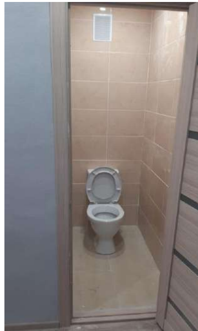
Фото 4. Санузел (5-ый этаж)
