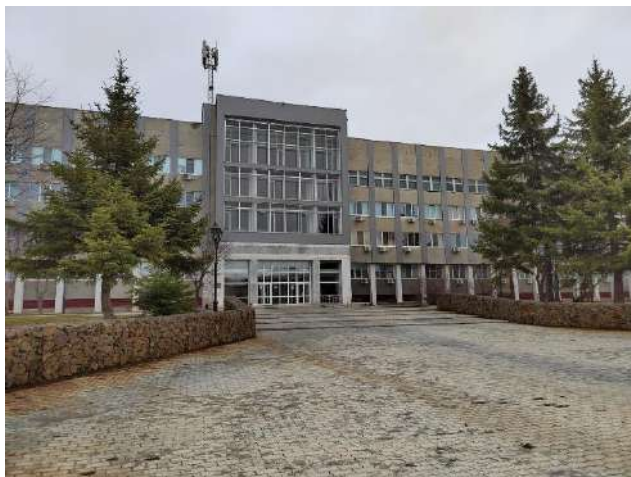
Фото 1. Внешний вид здания
